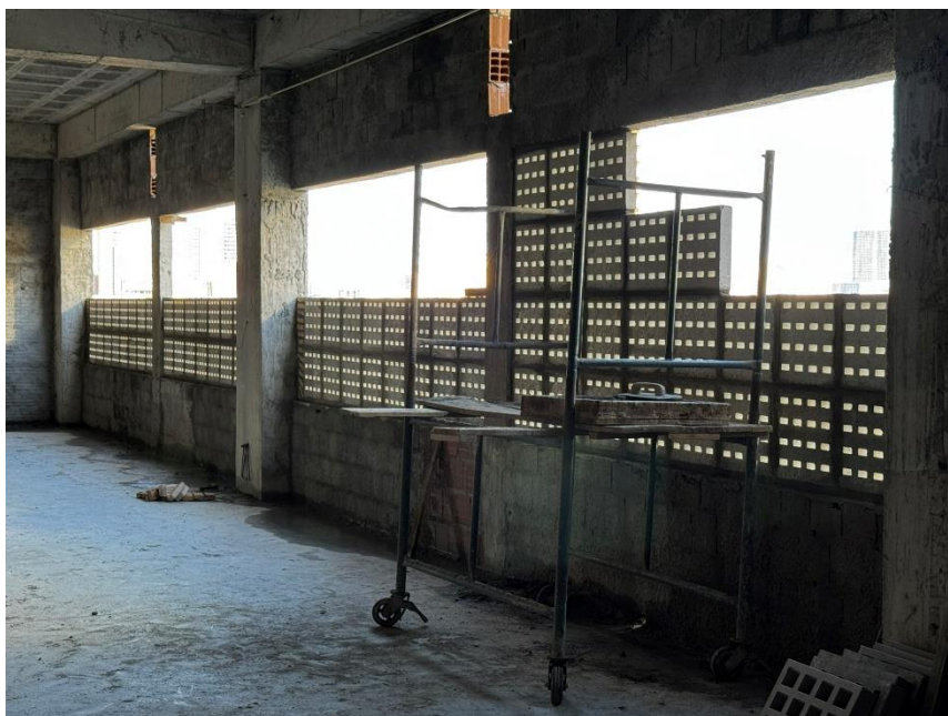
Figura 7. Instalação dos cobogó no semi enterrado 1..
