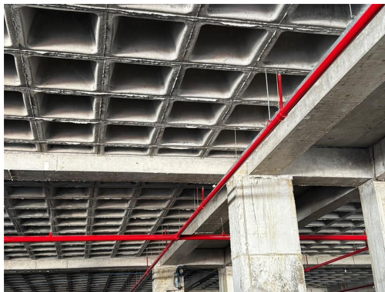
Figura 11. Instalação das tubulações de aço galvanizado no segundo semi enterrado.
