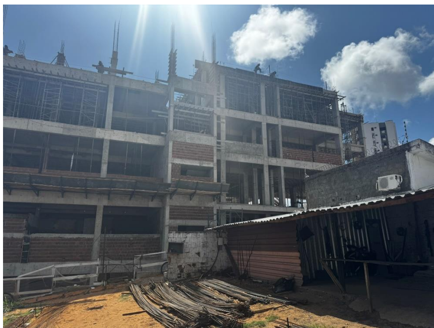
Figura 6. Elevação de alvenaria dupla nas escadas.
