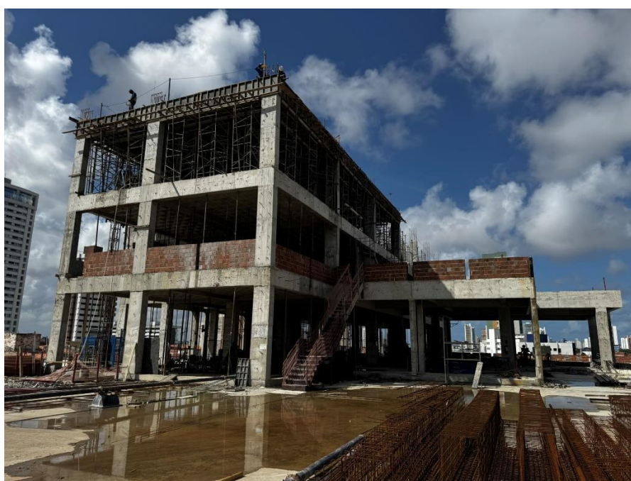
Figura 4. Visão da fachada sul com a concretagem da primeira metade da laje de cobertura do segundo pavimento.
