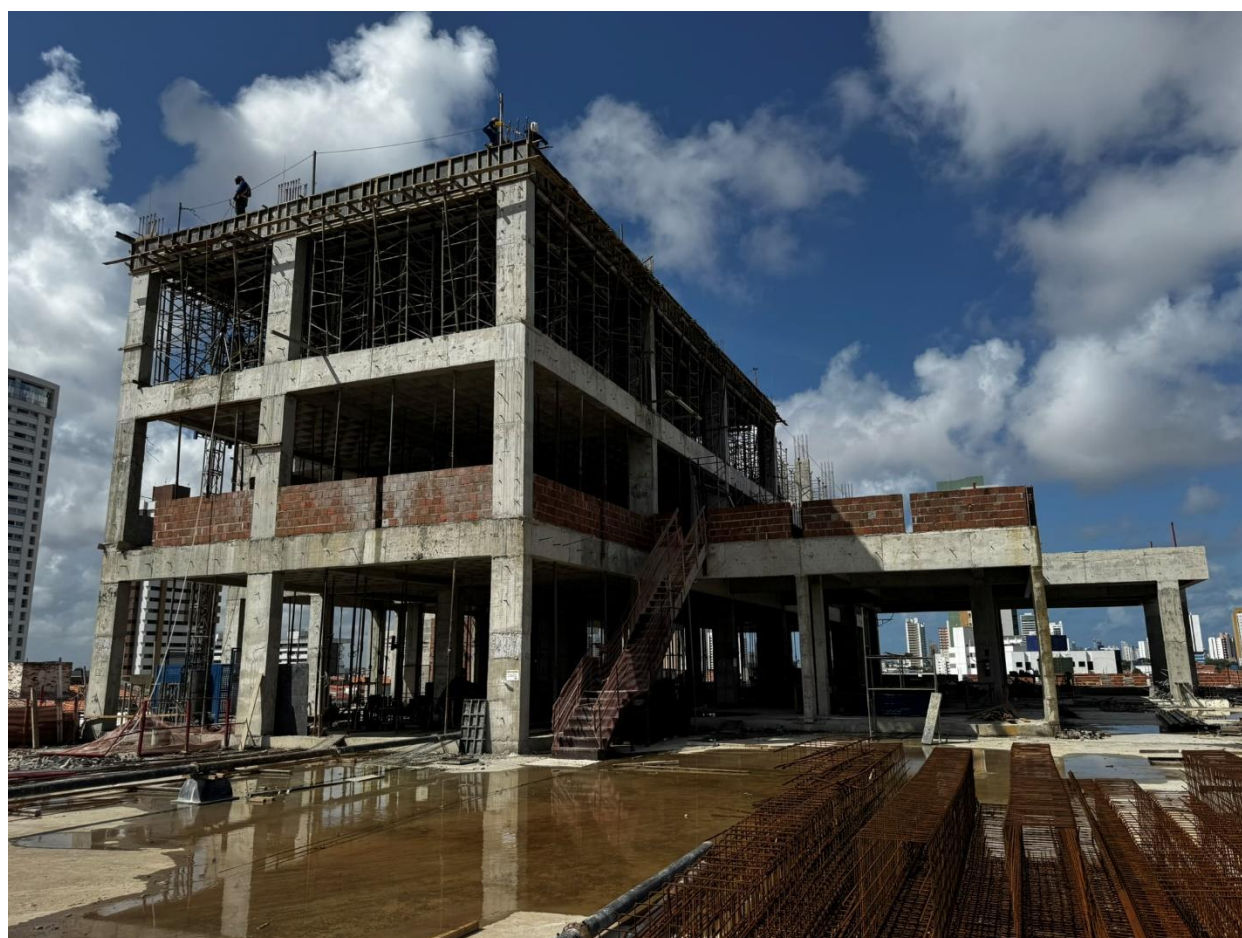
Figura 1. Visão geral da obra.
