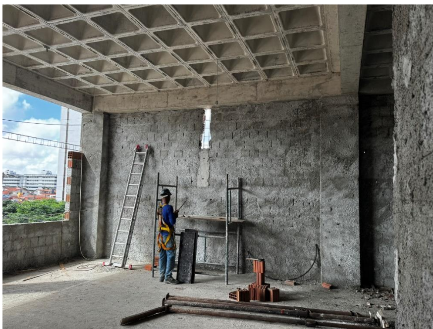
Figura 10. Execução de vergas e pilares de travamento nas alvenarias.
