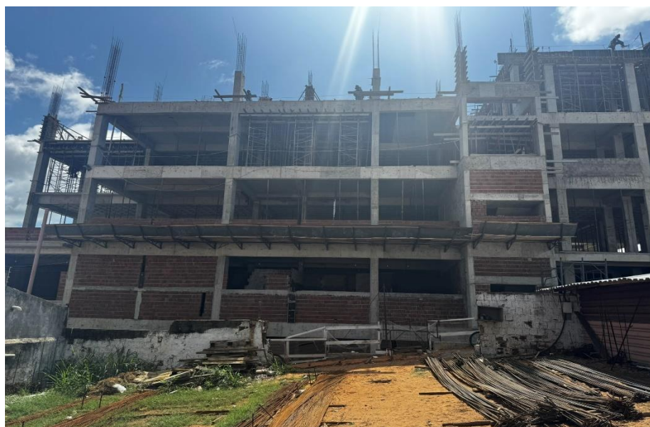
Figura 5. Montagem e concretagem dos pilares do segundo pavimento.
